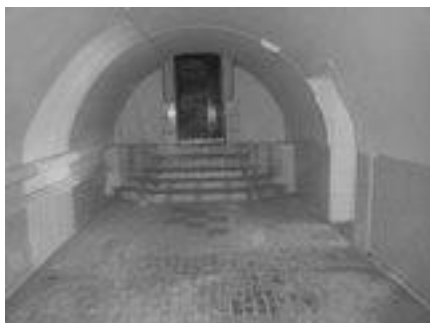
Рис.1. Вид холла с входа из главного зала (фотография)
