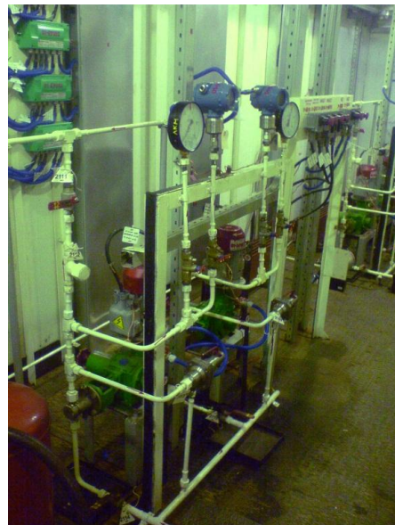
Рис. 2. Внешний вид блока насосов-дозаторов
